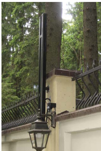
Датчик FOSTER на кирпичной ограде
