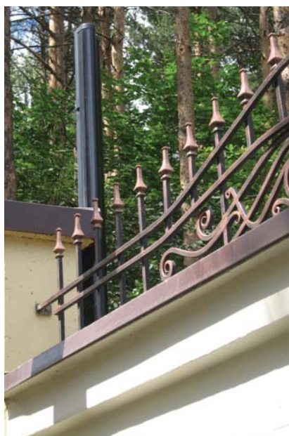
Датчик FOSTER на кирпичной ограде
